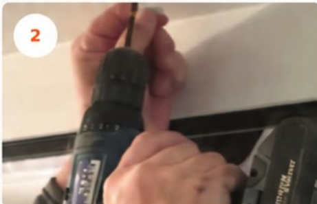
Bohrungen durchführen und Clipse befestigen
