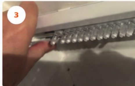
Oberschiene schräg ansetzen und einklicken
